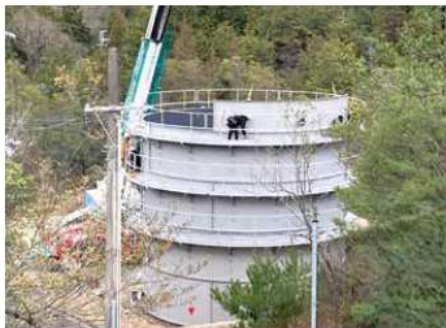
▲仮設タンクの組立
