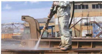
孔食(錆コブ)除去
