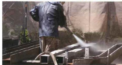
鋼材の塗装面のクロカワ除去
