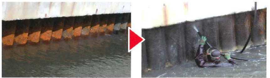
護岸用鋼管のメンテナンス
