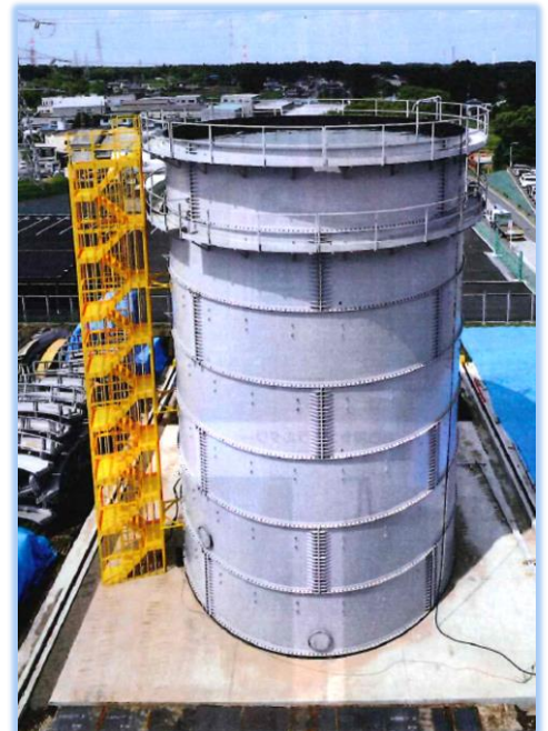
大容量鋼製組立タンク 2100m 3
